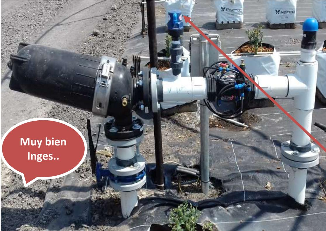
Crucero de válvula con filtro de control angular.
