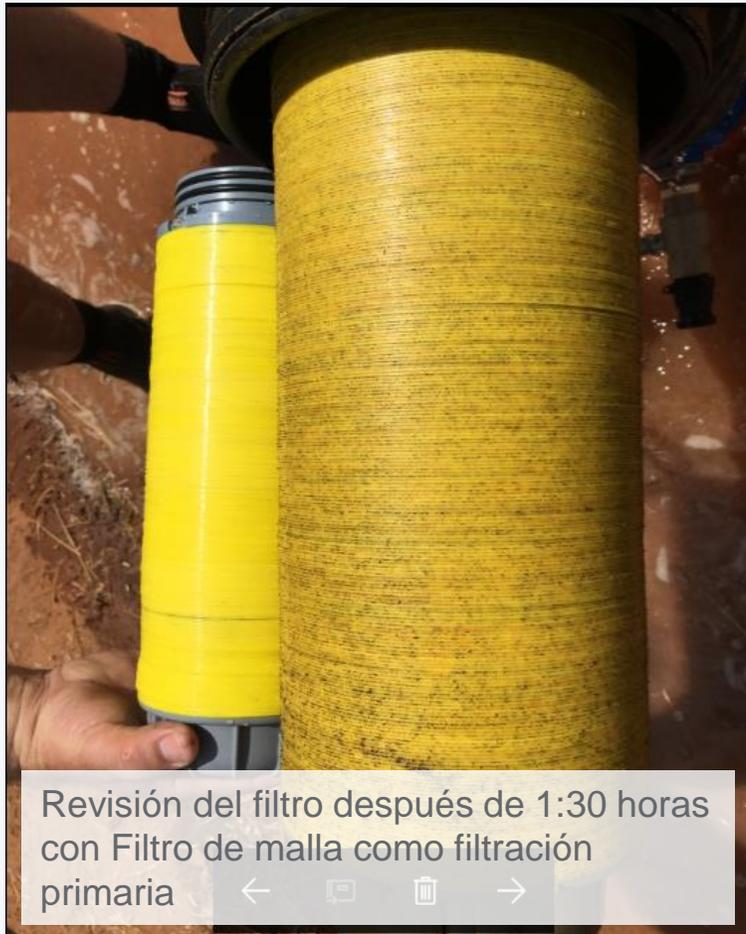
Revisión del filtro después de 1:30 horas con Filtro de malla como filtración primaria
